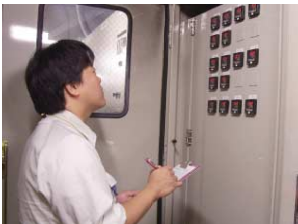
設備運転状況の確認
