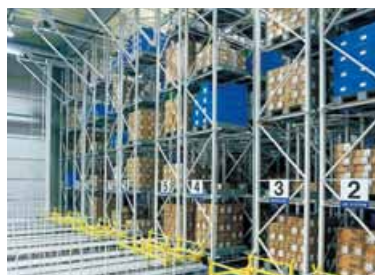
塩尻物流センター立体自動倉庫
