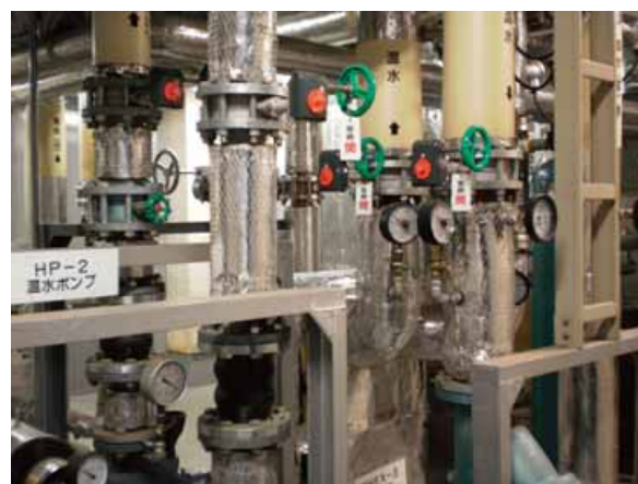
ボイラーの断熱
